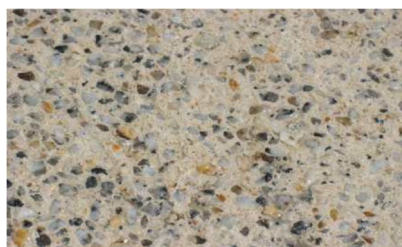
Application of B-REPARA PROTEÇÃO AD 40
